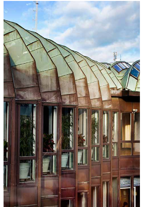
Riksbankshusets takväning mot innergården. Hela vägen längs gårdsfasaden står gröna växter i höga, vita krukor.
